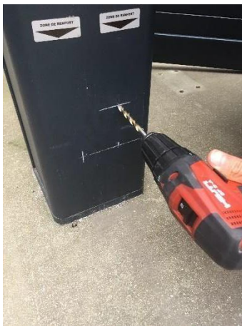
Orificio Ø 6,5 mm
