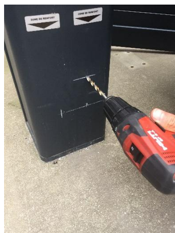
Perforación Ø 6,5 mm
